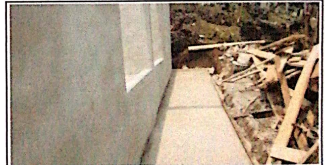
FOTO 6: SUSTITUCION RAMPAS Y VENTANAS.
