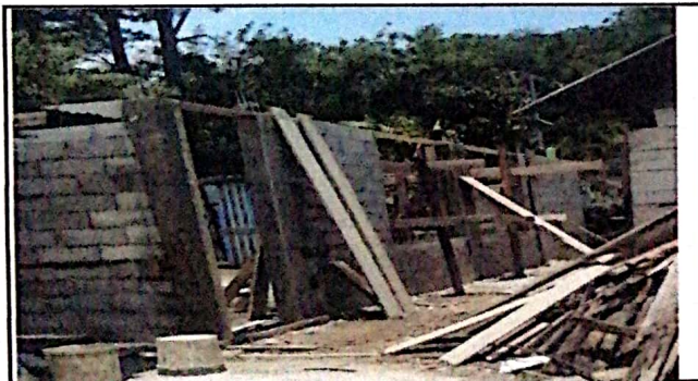
FOTO 3: SUSTITUCION DE COLUMNAS DE CONCRETOS.
