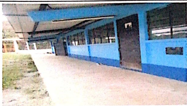
FOTO 1: PINTURAS DE DOS AULAS
