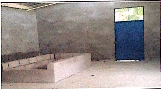
FOTO 3: SUSTITUCION DE PISO Y POLLETON DE LA COCINA.
