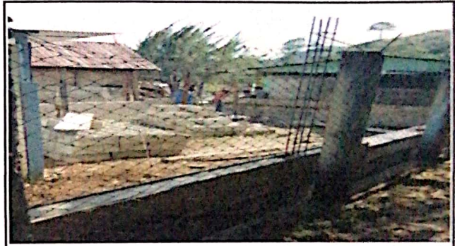
FOTO 2: SUSTITUCION DE SOLERA DE INTERMEDIA.
