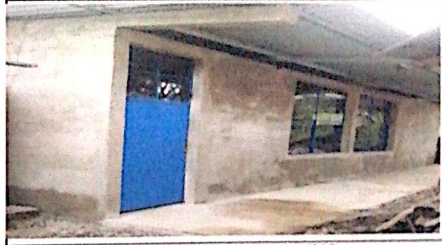
FOTO 2: SUSTITUCION DE 2 PUERTAS DE METALICAS
