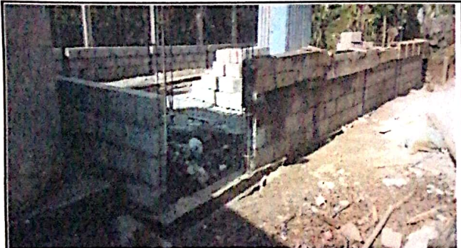
FOTO 1: SUSTITUCION DE MURO DE CONTENCIÓN DE COCINA DE 6M X 10M
